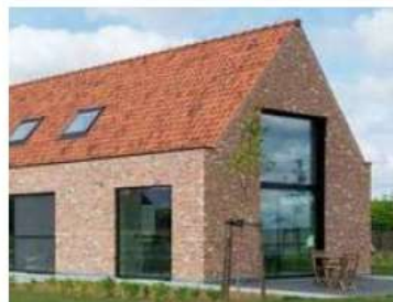
Terugkerende gevelopeningen in de zijgevels
