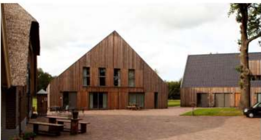
Aantrekkelijke kopgevels met ritmische openingen naar het woonef toe
