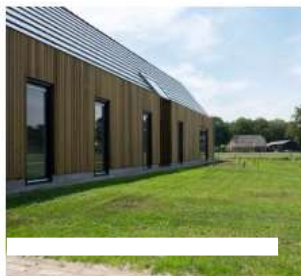
Openingen in de zijgevel doorgezet in het dak
