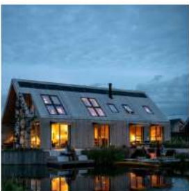
Terugkerende gevelopeningen in de zijgevels
