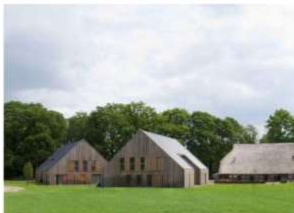
Woningen aan het erf vormen een cluster in het landschap
