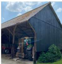
Bestaande kapschuur op het erf
